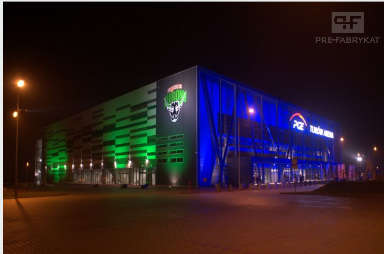
Hala widowiskowo-sportowa w Zgorzelcu.
