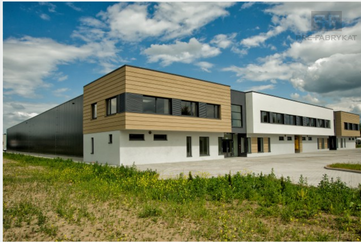
Hala produkcyjno-magazynowa w Świdnicy
