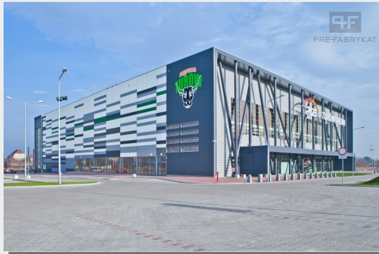
Hala widowiskowo-sportowa w Zgorzelcu.
